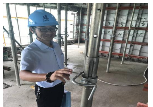
2017.9.22 常州市组合铝合金模板施工现场观摩会
