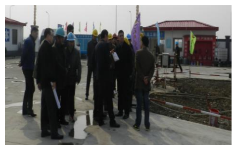
2016 年 3 月 11 日, 新北区区长到电商大厦施工现场检查工作
